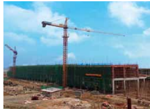
江門星輝造紙有限公司 白板紙工場建屋(建設中)
