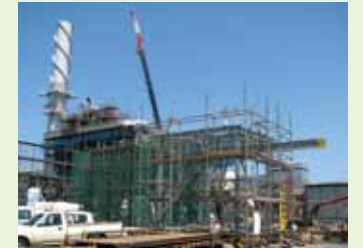
新潟工場新発電設備(建設中)
