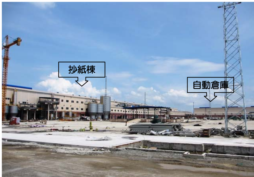
構内からの建屋外観
