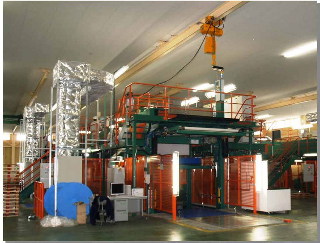
2013/4完工 新潟工場 6-4-6-5カッター (写真は6-5カッター)
