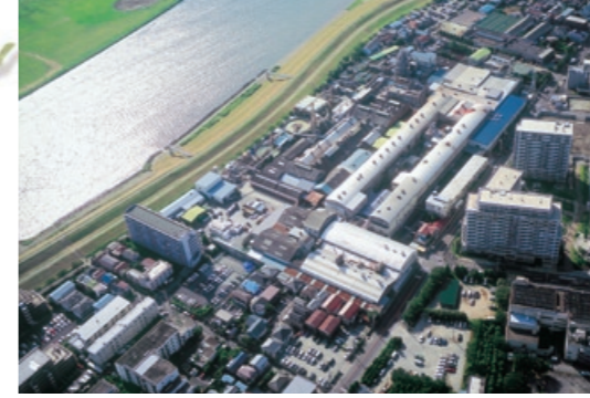
C 関東工場[市川](千葉県市川市)
