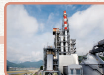
回収ボイラー・発電機
