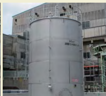
新設された過水タンク(新潟工場)
