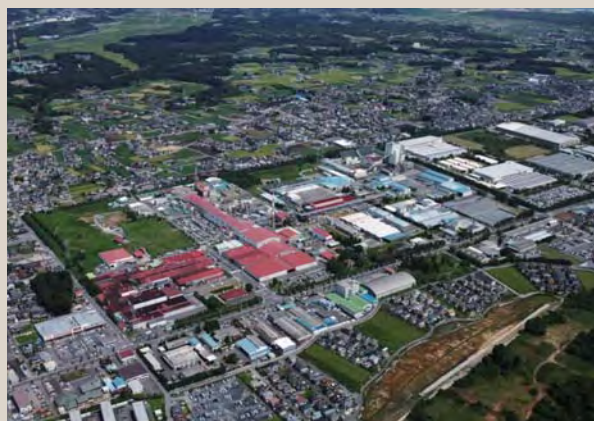
関東工場勝田工務部
