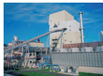
関東工場(勝田) 木質バイオマスボイラー
