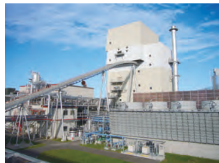
関東工場勝田にある日本最大級のバイオマスボイラー
