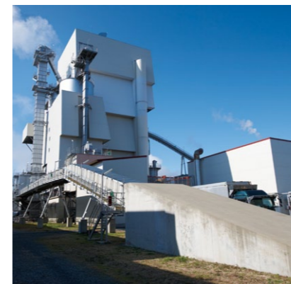
関東工場(勝田)の木質バイオマス発電ボイラー。発電量は4万1千kw。工場がピーク時に使用する電力の2倍以上の発電量があるため、余剰電力は外部へ販売しています。
