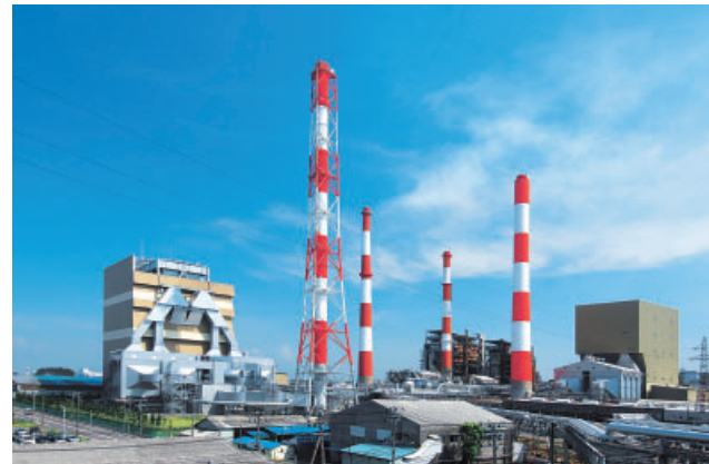
新潟工場ボイラー／Boilers at Niigata Mill
