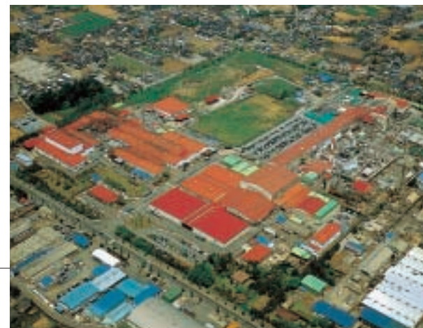
関東工場勝田工務部 Kanto Mill Katsuta
