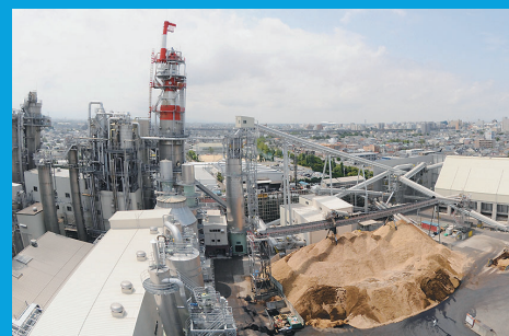
▼ 構内チップヤードとパルプ生産設備
