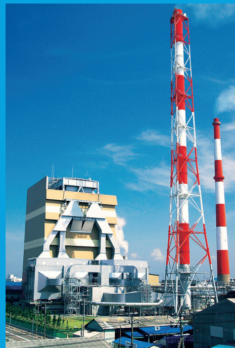
▼ バイオマスボイラー
