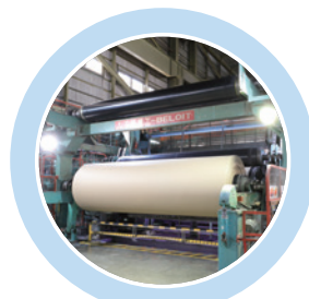
新潟工場の6号抄紙機を改造
