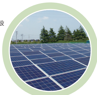
関東工場(勝田)のメガソーラー発電設備
