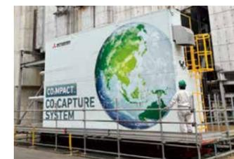
ソーダ回収ボイラーから排出するCO<sub>2</sub>を分離回収する技術の実証試験を2024年11月から新潟工場において開始しました。本実証試験では、三菱重工業(株)の小型CO<sub>2</sub>回収装置(CO<sub>2</sub>MPACT™モバイル)を設置し、ソーダ回収ボイラーの排ガスに含まれるカーボンニュートラルのCO<sub>2</sub>を分離回収します。
