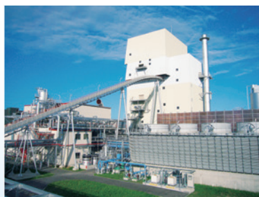
木質バイオマスボイラー(関東工場(勝田))
