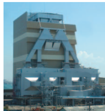
新潟工場8号回収ボイラー The No.8 recovery boiler of Niigata Mill
