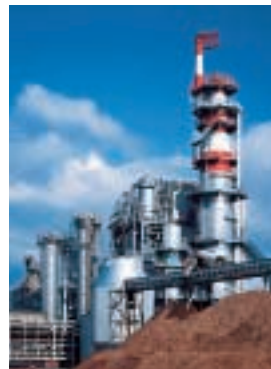
ECFパルプを製造する連続蒸解釜 Continuous digester producing ECF pulp
