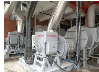
江門星輝造紙 リニア真空ポンプ (従来品に比べ37%の消費電力削減に成功)
