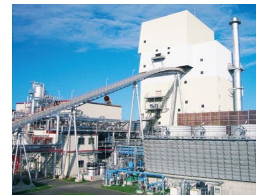
■ 関東工場(勝田) 当時、国内最大級の木質 バイオマスボイラー
