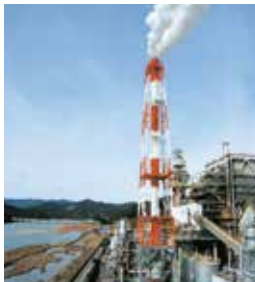
排煙脱硫装置
