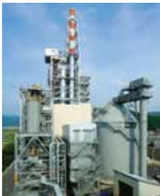
バイオマスボイラ
